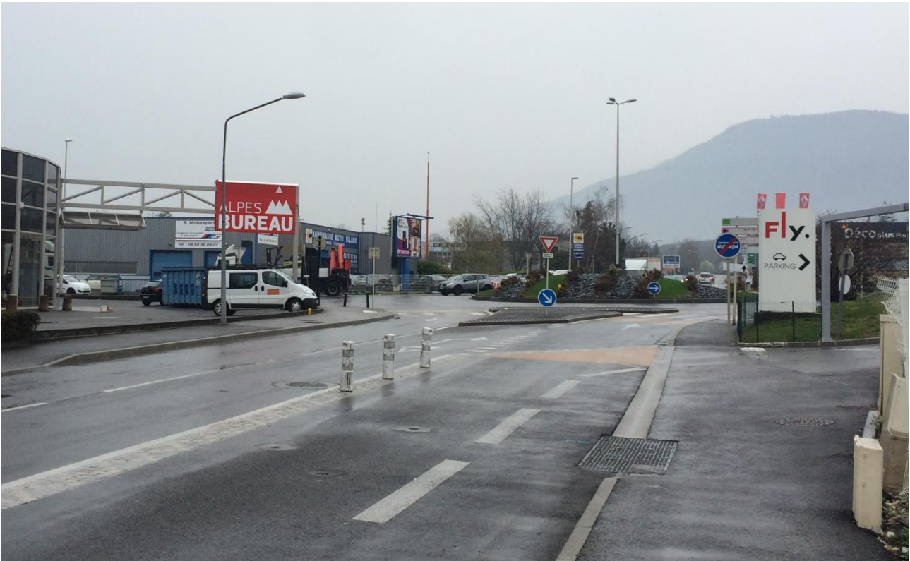
Figure 20 – Exemple d'interruption de la voie BHNS en entrée de giratoire
