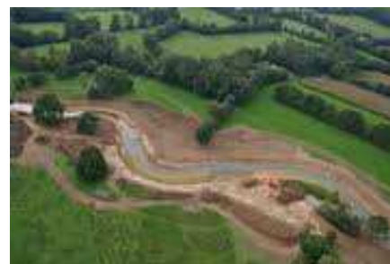
Exemple de renaturation de la Veyle (01) (Source www.eaurmc.fr )
