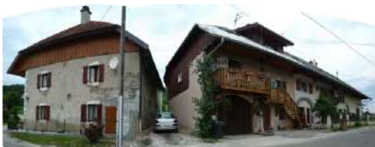
Bâtiment patrimonial Route de Chez Levelt
