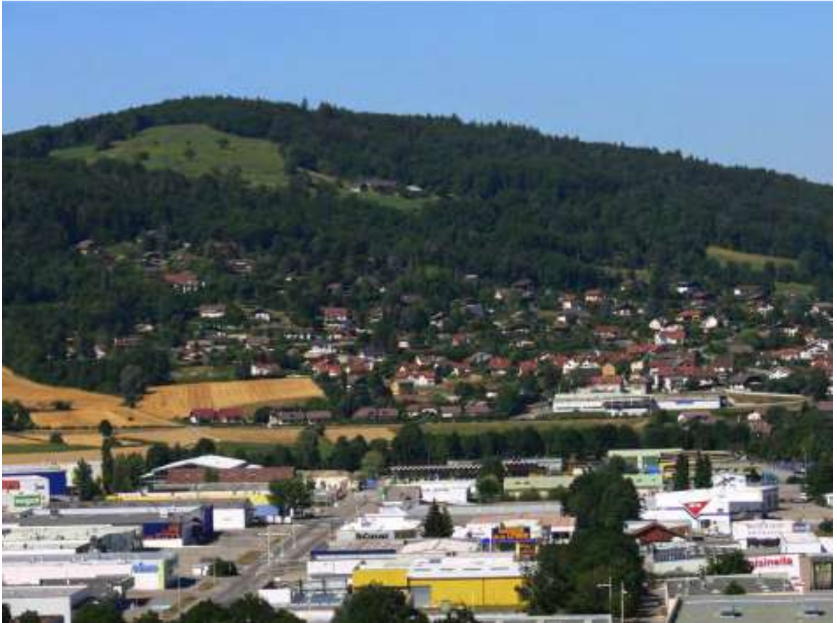
Le centre commercial du Grand Épagny et le quartier de Saint-Paul, séparés par le fossé des Maraichères et le domaine agricole de Chez-Moutier. Un espace ouvert de transition qui favorise la lisibilité paysagère.
