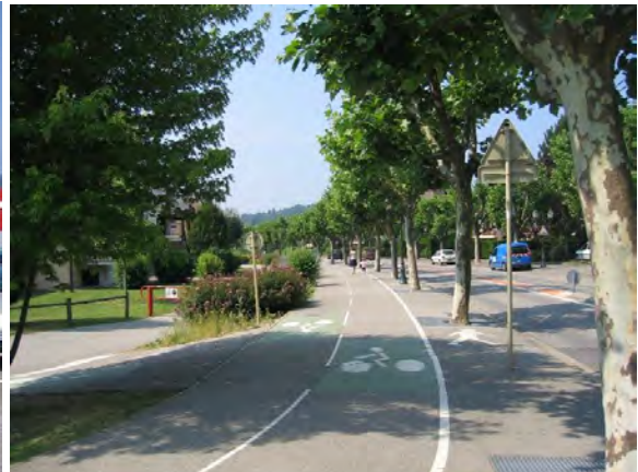
Bande cyclable le long de la rue de la Tuilerie
