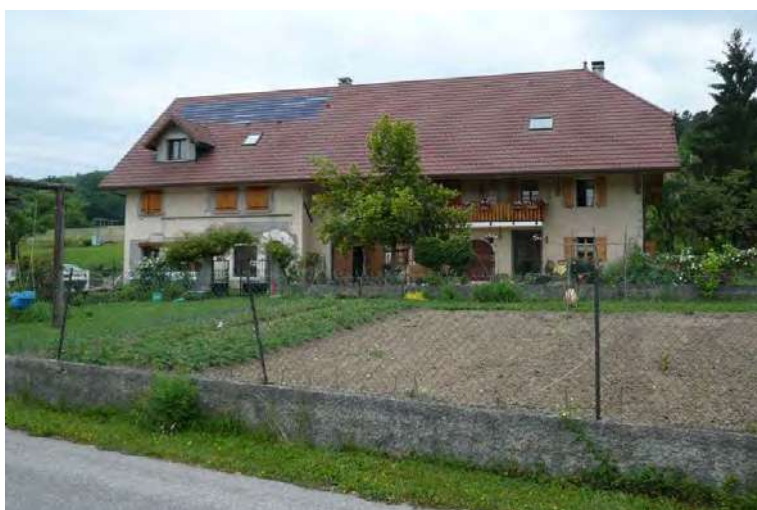
Bâtiment patrimonial Route de Chez Levelt
